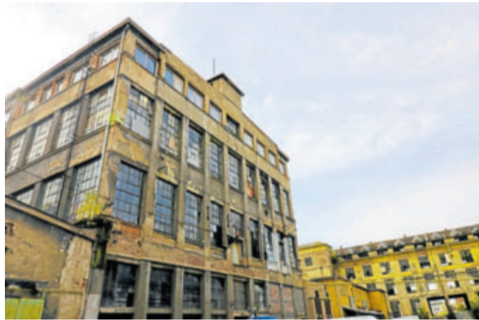
ZE ZANEDBANÉHO KOMPLEXU se stane bytový areál. Dokončení rekonstrukce je plánováno na podzim roku 2024.
